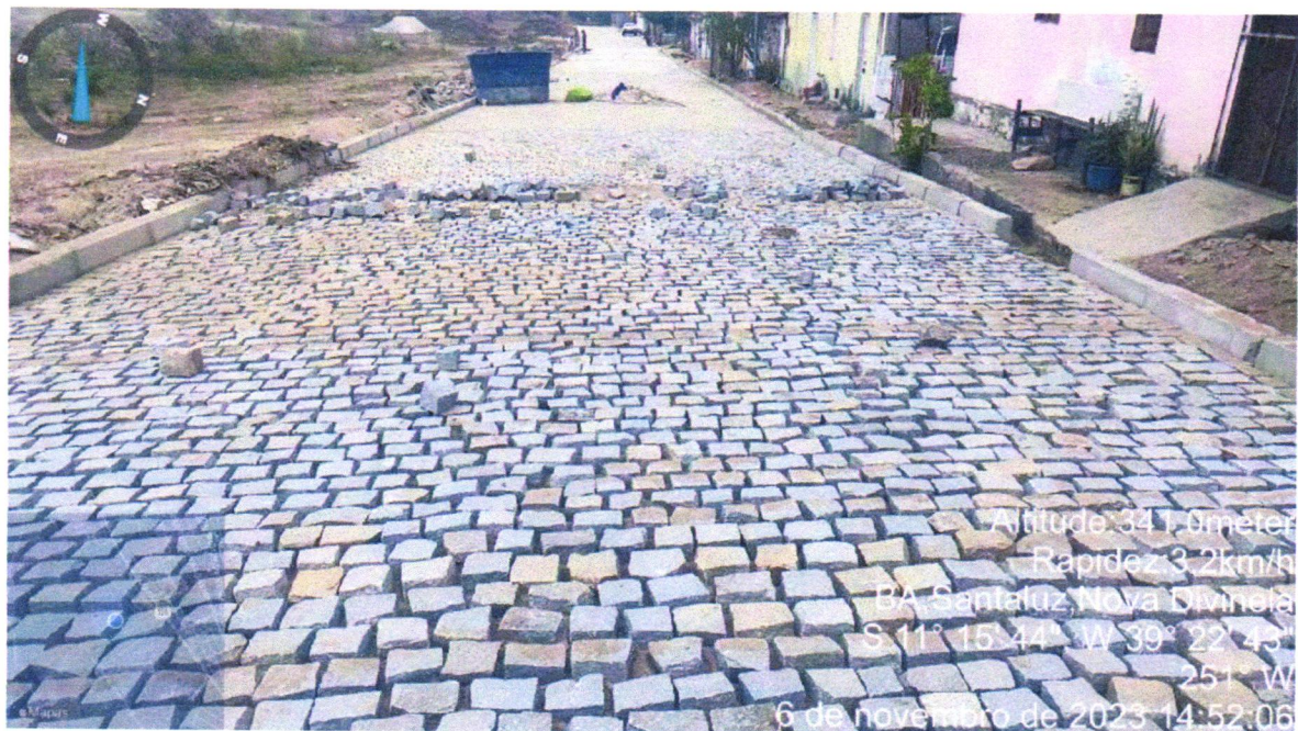
Execução de Pavimentação do Bairro Nova Divinéia, Rua F. Mascado
